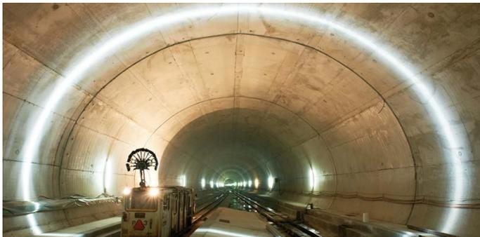
Um die Sicherheit von Tunneln gewährleisten zu können, müssen diese regelmäßig auf Defekte wie Risse, Steine, Steinsplitter oder Korrosion untersucht werden. In der Vergangenheit wurden die Kontrollen überwiegend vom Tunnelpersonal mit Hilfe von mobilen Gerüsten durchgeführt. Diese Methode ist jedoch sehr zeit- und arbeitsaufwendig und birgt die Gefahr, dass beispielsweise Risse übersehen oder nicht frühzeitig erkannt werden.
